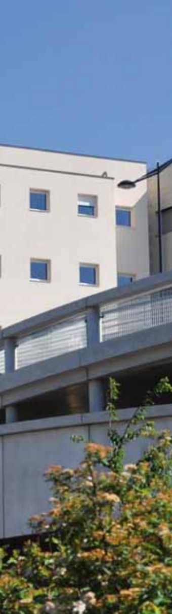
The Alexis Vautrin Centre in Vandoeuvre-les-Nancys, France.
